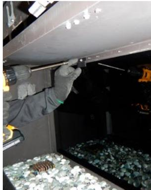
**Étape 5:** Une fois que les panneaux arrière sont sécurisés, les 2 panneaux latéraux peuvent être installés.
