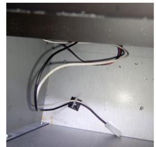
6. Alimenter le fil LED à travers le tiroir. Attacher au plancher de la chambre de combustion sur le côté droit de l'unité.
