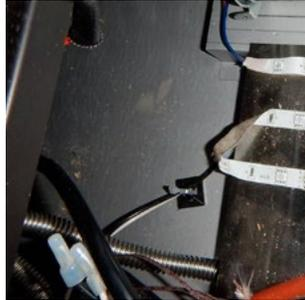
7. Enfilez le fil du ventilateur dans le tiroir et placez-le sur le plancher du foyer avec un tampon adhésif. Pour les instructions d'installation du ventilateur, reportez-vous à la section Instructions d'installation / remplacement du kit de ventilation
