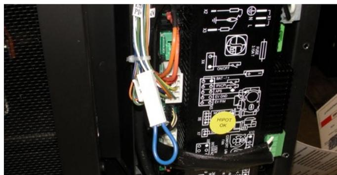
Figure 19.c Raccordez le câble de raccordement
