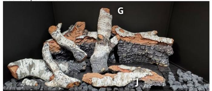
**étape 5:** Reposez la bûche M avec les extrémités sur la bûche J et B. La bûche D est placée dans le coin avant droit, côté carbonisé vers l'intérieur.
