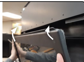
Figure 21.b Installation de la porte
